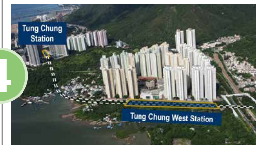
MTRC 1201 - Tung Chung West Station and Tunnels – Bouygues - Dragages JV 東涌綫延綫東涌西站及隧道建造工程 (合約編號: 1201) – 布依格香港寶嘉聯營
