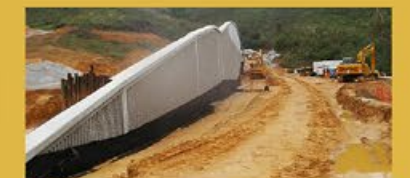
Sandy Ridge Cemetery construction site 興建中的沙嶺墳場
